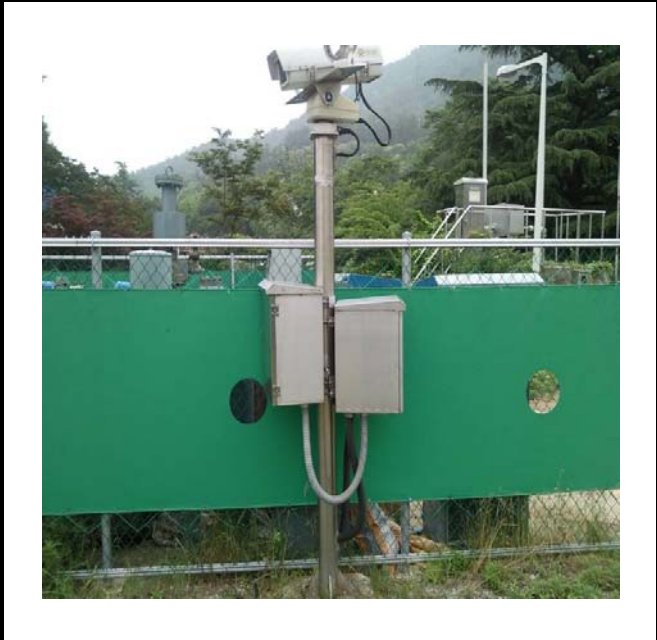
공사설명 10. 발전소 사옥 후문 감시 카메라 함체설치
