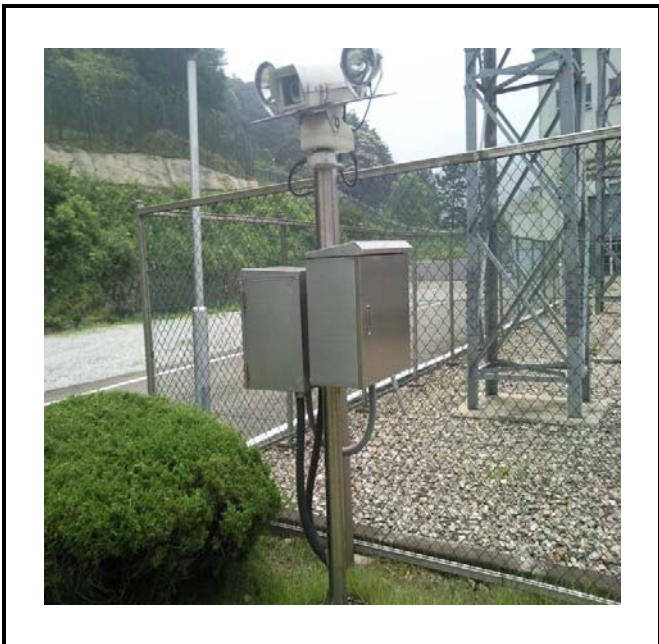
공사설명 2. 옥외S/S 앞 감시 카메라 합체설치
