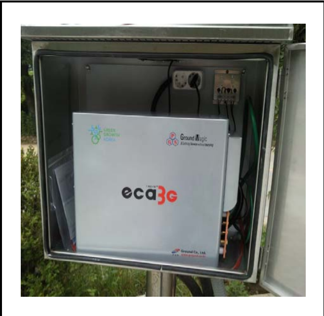
공사설명 9. 발전소 사옥 정문 감시 카메라 장비설치
