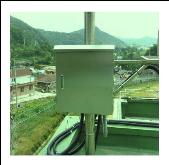
공사설명 7. 발전소 옥상 울타리 감시 카메라 함체설치
