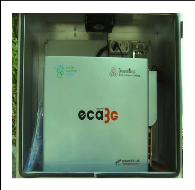
공사설명 4. 취수구 내부 감시카메라 장비설치
