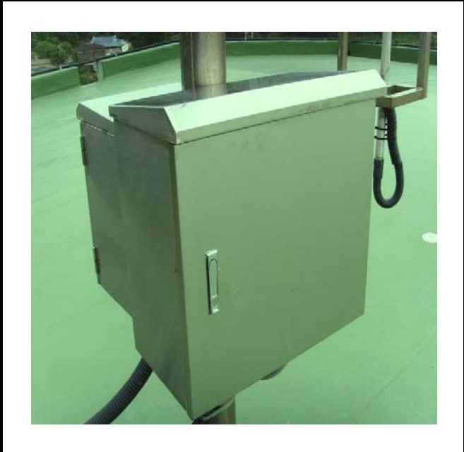
공사설명 8. 발전소 옥상 수압철관 감시 카메라 합체설치
