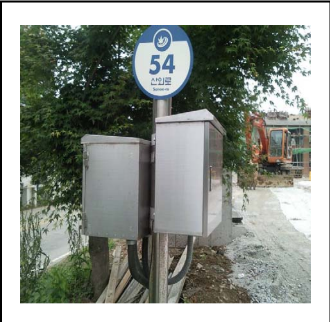
공사설명 9. 발전소 사옥 정문 감시 카메라 합체설치
