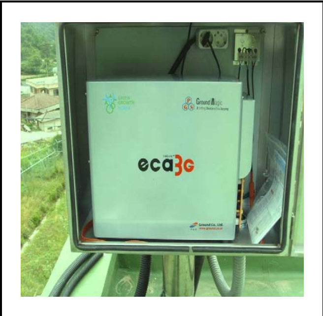
공사설명 7. 발전소 옥상 울타리 감시 카메라 설치 후
