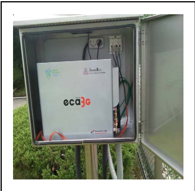
공사설명 2. 옥외S/S 앞 감시 카메라 장비설치
