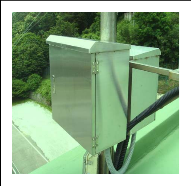
공사설명 6. 발전소 옥상 S/S감시 카메라 함체설치
