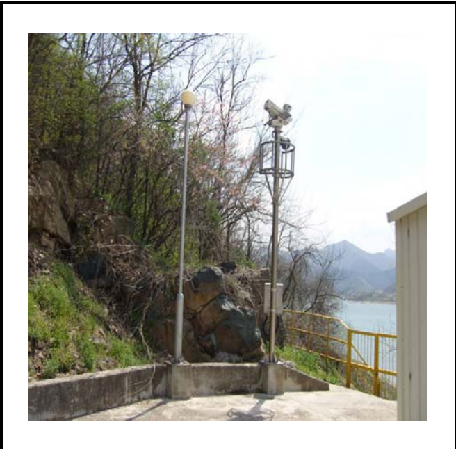
공사설명 4. 취수구 내부 감시카메라
