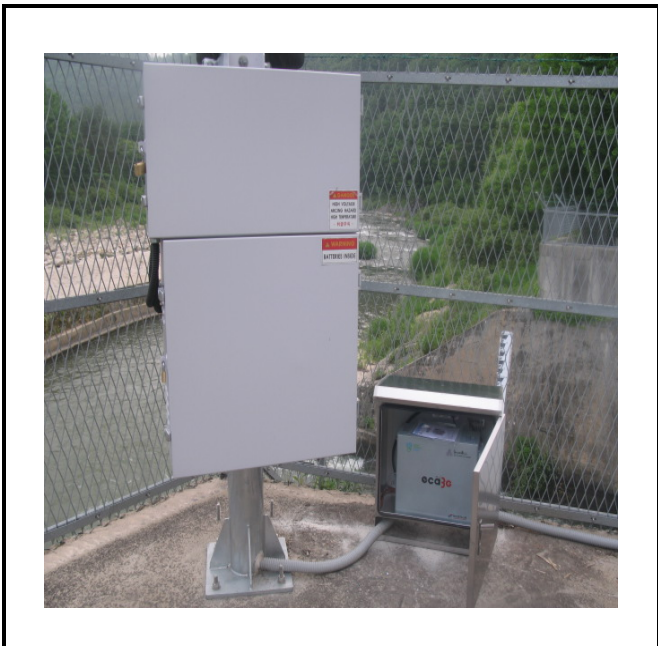
공사설명 1. 방류예경보 제1국 장비설치
