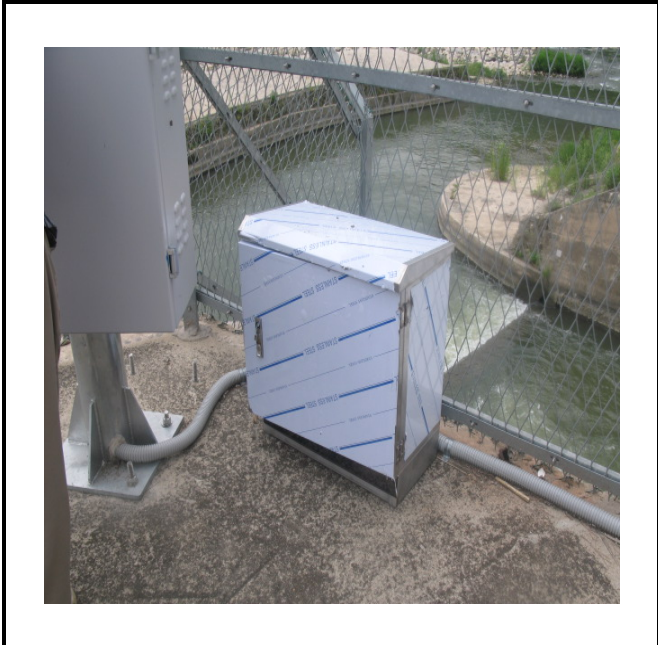
공사설명 1. 방류예경보 제1국 합체설치
