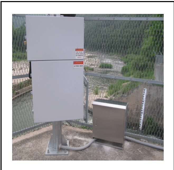
공사설명 1. 방류예경보 제1국 합체설치
