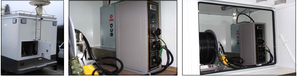
그림-5 국군00사령부 전파측정차량 eca3G 설치(2007.11)
