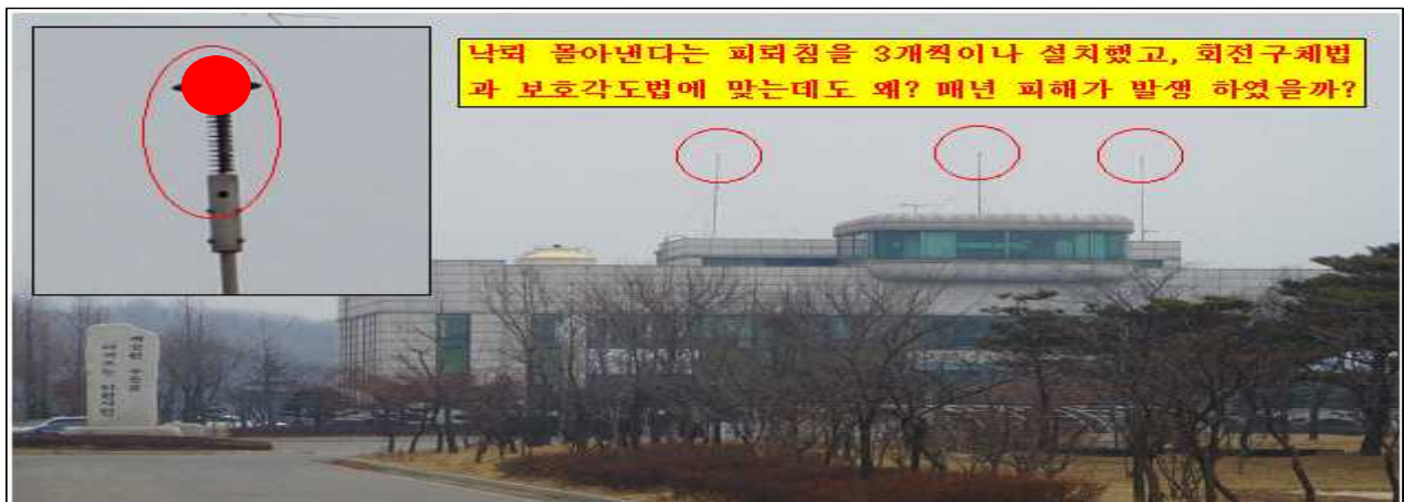
그림-3 몰아낸다는 피뢰침 3개나 달았다, 보호범위도 맞다, 왜 낙뢰피해가 발생할까?
