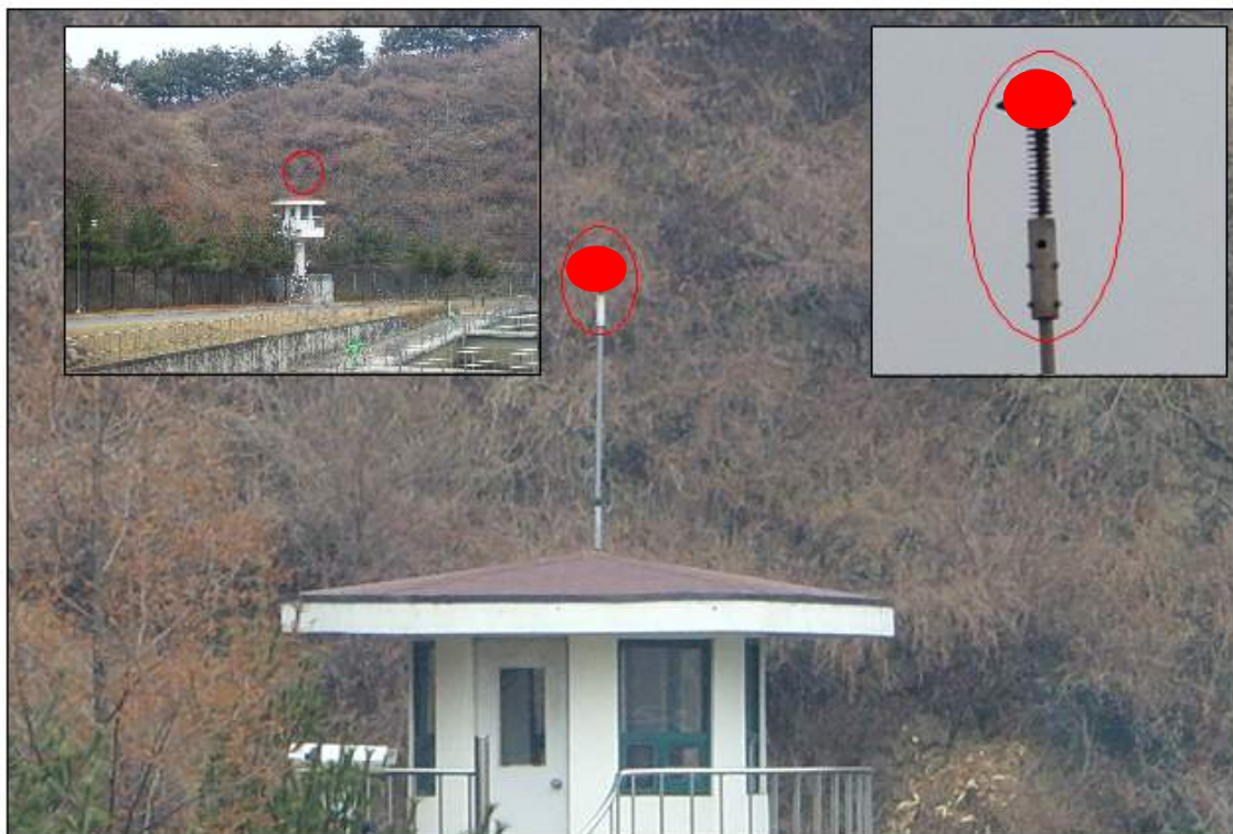
그림-2 언덕 밑 경비초소에 낙뢰가 올까? 오지도 못하는데 낙뢰를 몰아낸다?
