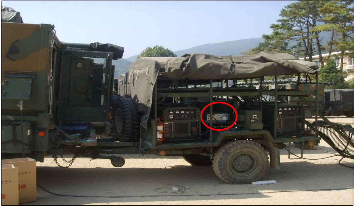
그림-8 지원차량(발전기)에 3세대 접지장치(eca3G) LM Series 설치(2008.12)
