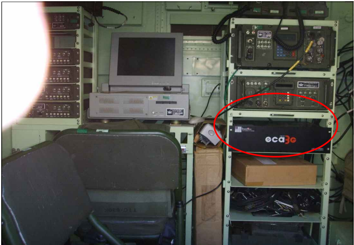
그림-9 통신차량 통신 Rack에 3세대 접지장치(eca3G) CM Series 설치(2008.12)
