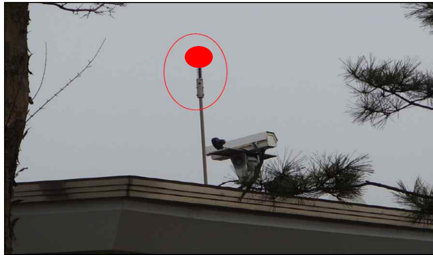
그림-1 소나무 아래, 또 5 m도 안 되는 초소위에 설치된 불필요한 피뢰침
