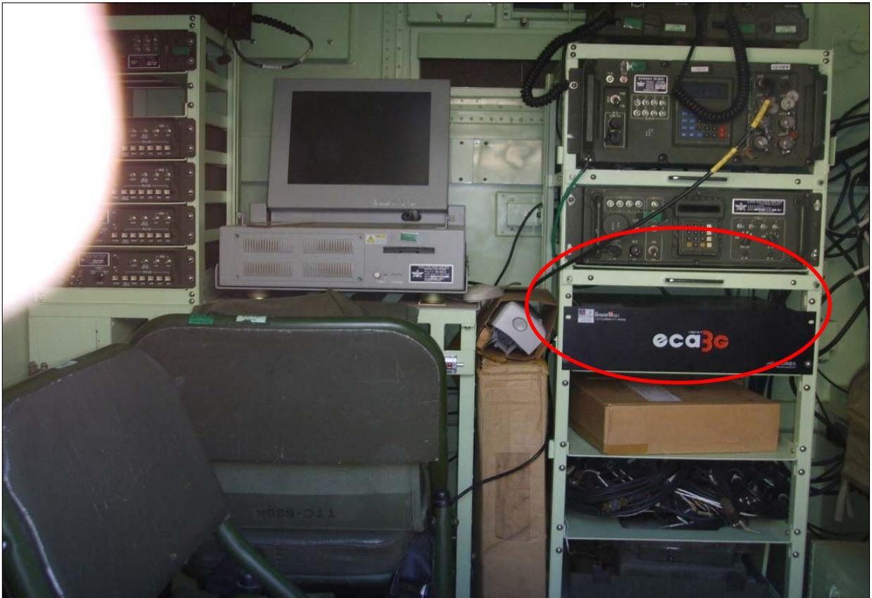
그림 14. 통신차량 통신 Rack에 3세대 접지장치(eca3G) CM Series 설치(2008.10)
