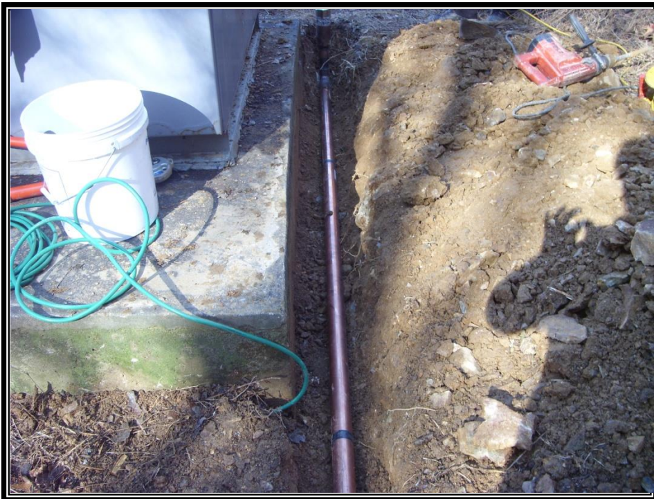
PGS L형 접지봉 설치-2
