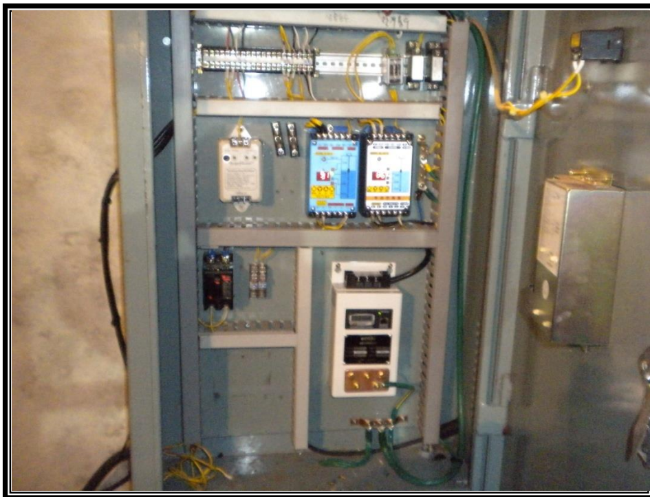
통신용 보호기 설치-2
